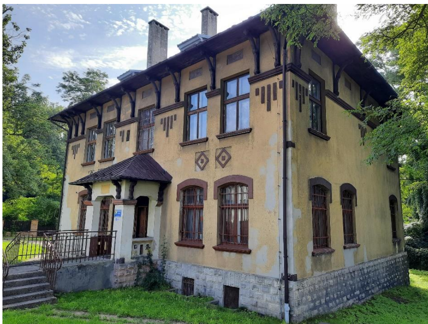
Fot. 8. Willa dyrektora kopalni „Janina” przy ul. Kopalnianej z lat 1928-1931
